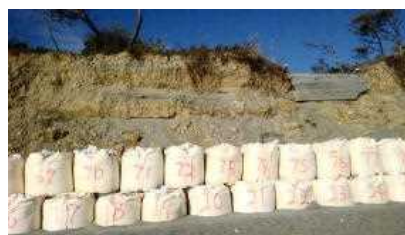
高波により削られた防潮堤の階段
